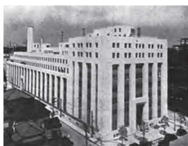
⑦ 仮設庁舎
