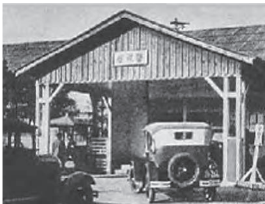
⑤ 馬場先門内仮設庁舎
